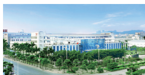
Завод в г.Жангжоу
